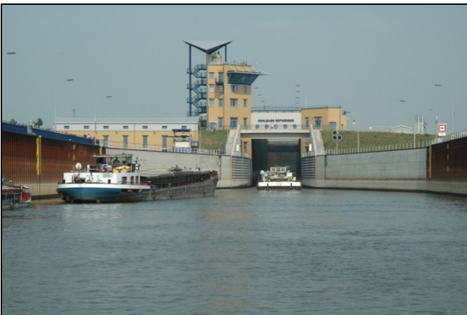
Im Rahmen des Baues des Wasserstraßenkreuz entstand auch die Schleuse Rothensee, die das alte Schiffshebewerk Rothensee weitgehend überflüssig machte. Foto: Kurt Pflüger
