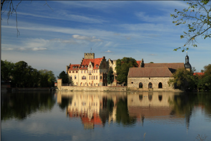
Die Wasserburg Flechtingen von 1307 ist eine der besten erhaltenen Anlagen in Sachsen-Anhalt. Foto: Kurt Pflüger
